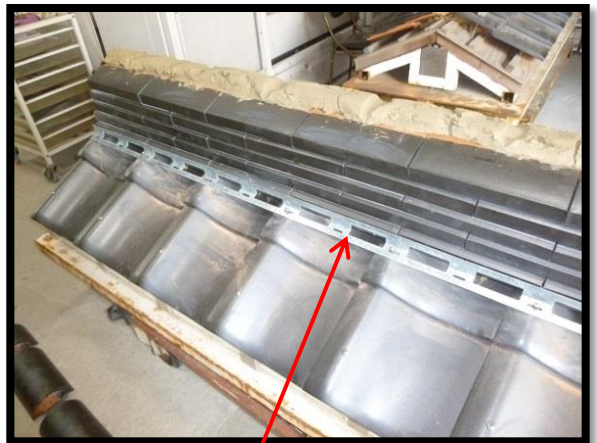
④のし固定用外付け金物を設置します。
