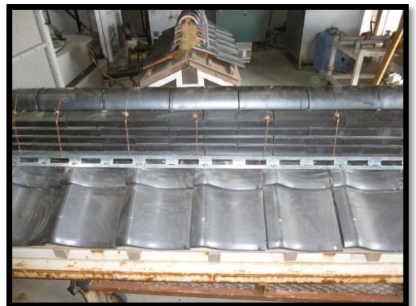
⑥棟耐震簡易補強の完成です。
