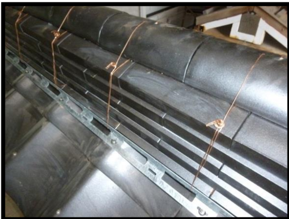
⑤冠瓦と外付け金物を棟の両側で引張り合うように緊結します。
