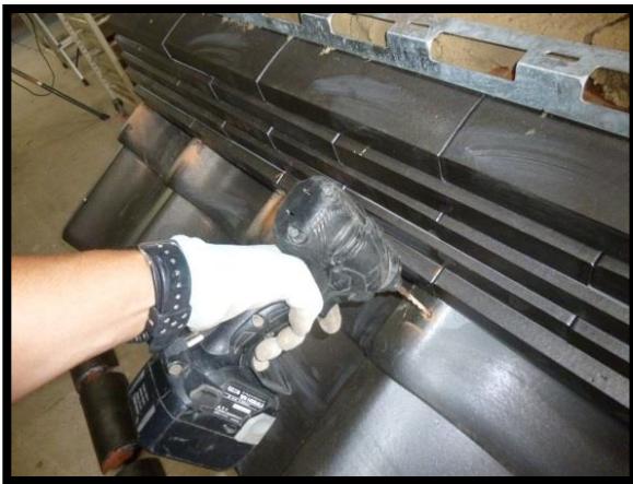
③棟際の棧瓦の山部に孔を開けます。
