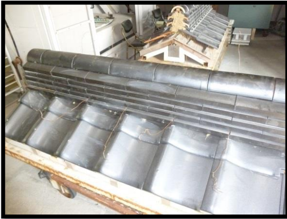
①既存棟の銅線を外します。
