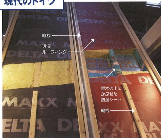
欧州の見本市で展示されていた屋根の下のモデル。垂木を防湿シートで覆って外部の湿気を遮断し、室内の湿気は通り抜けられないようにしている。透湿ルーフィングに屋根材を留めるクギの穴が開かないようにするための縦棧を入れるのが特徴だ
