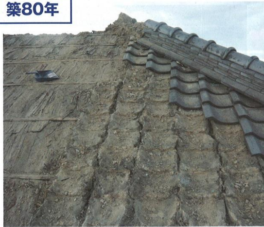
バラ板とスギ皮に土を載せて瓦を葺いた築80年の住宅の屋根。瓦の葺き替えのために瓦と土を取り除いたところ、劣化は見られなかった
